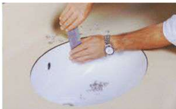
5. Dokładne wygładzenie krawędzi przy pomocy cykliny lub papieru ściernego
