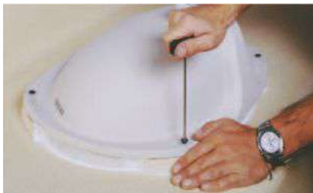
3. Przyklejenie miski przy pomocy kleju poliuretanowego oraz jej przykręcenie
