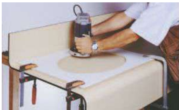
1. Obrysowanie i wycięcie otworu przy pomocy frezarki
