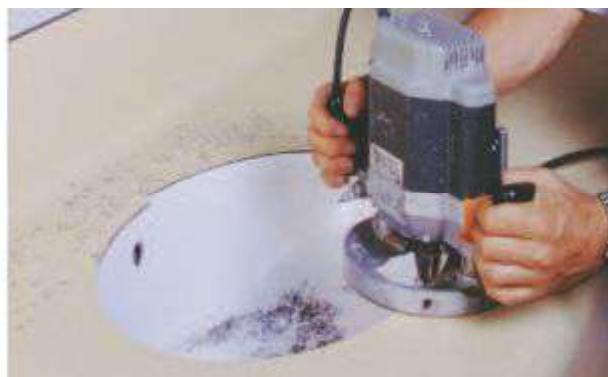
4. Frezowanie występu płyty Compact od strony widocznej przy pomocy frezarki ręcznej (frez ukośny!)
